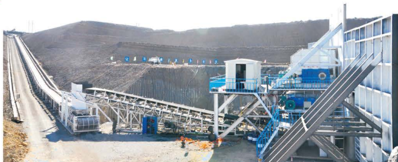
内蒙古锡林浩特大唐煤业胜利东二号露天矿3500t/h破碎站
