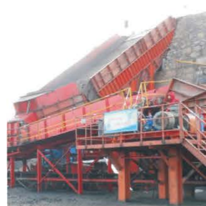
新疆保利吉朗德露天矿1000t/h破碎站
