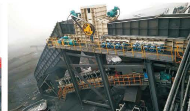
新疆金能矿业有限公司黑山头1200t/h原煤破碎站
