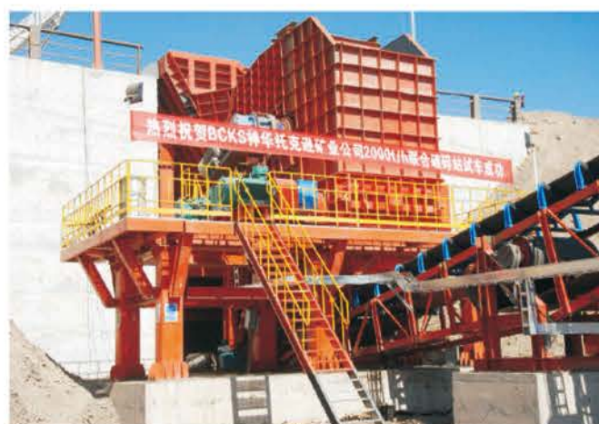
神华新疆托克逊黑山露天矿2000t/h破碎站
